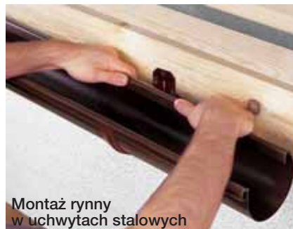
Montaż złączki rynny
