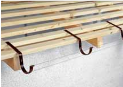
Montaż uchwytych stalowych prostych
